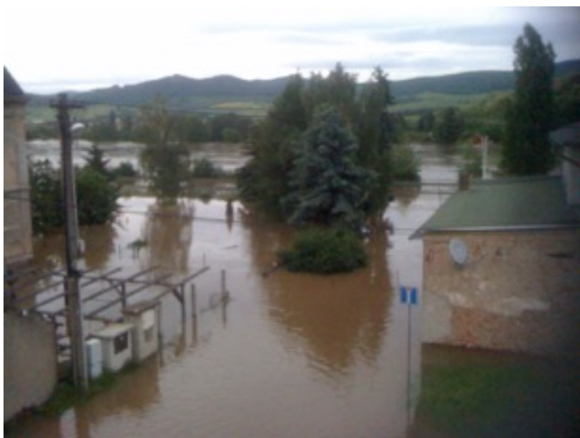
ČERPACÍ STANICE ČS8 - POVODEŇ
