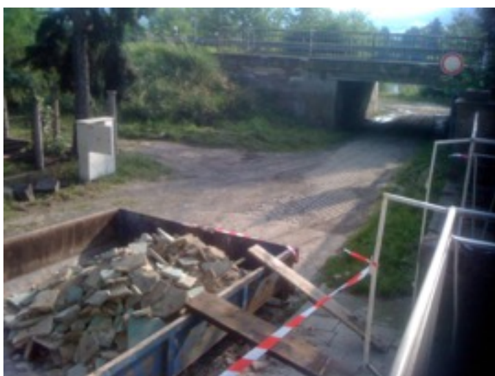
ČERPACÍ STANICE ČS8 - PO OPADNUTÍ VODY
